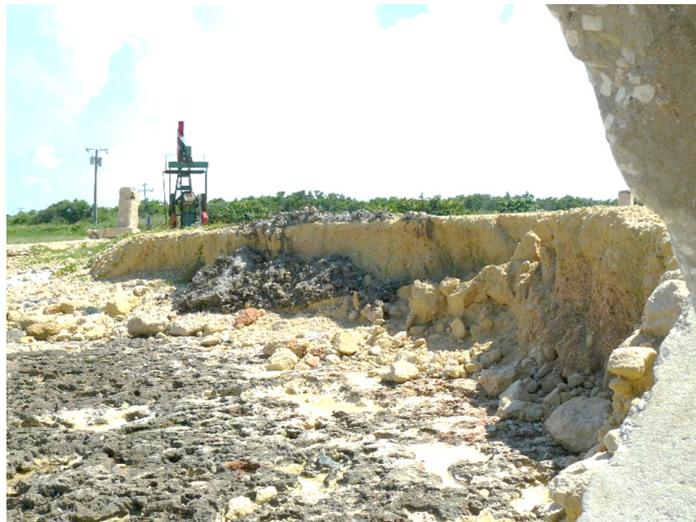
**Figura 9.** Desmantelamiento de la infraestructura de producción petrolera por erosión costera asociada a la elevación del nivel del mar (Foto del autor)
