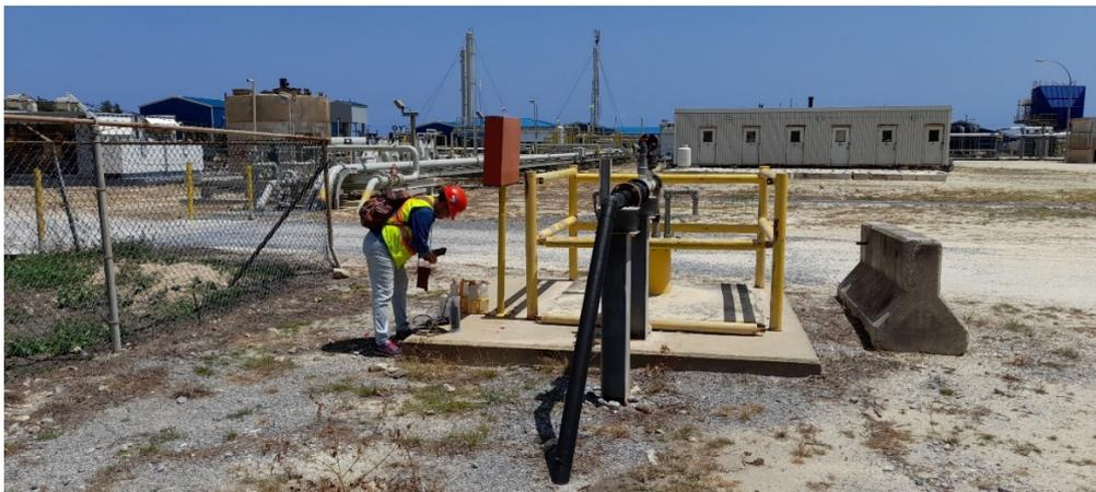
**Figura 10.** Estación de monitoreo del régimen y la calidad de las aguas subterráneas en Boca de Jaruco (Ana Margarita Sardiñas en la foto del autor)
