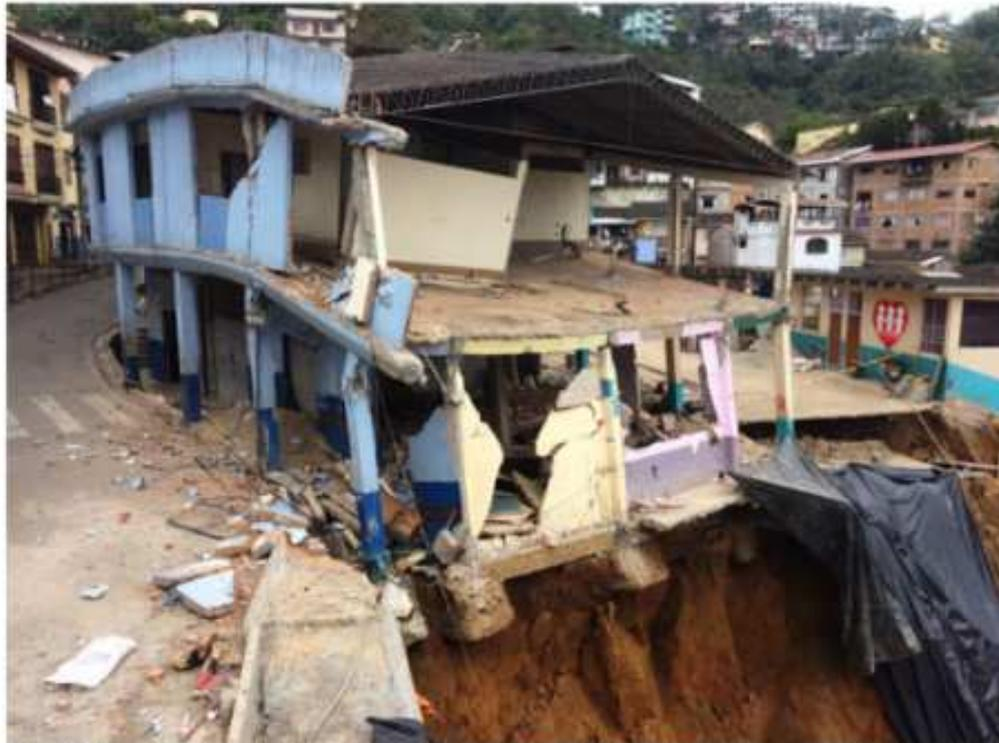
**Fig. 3. Cimientos y estructura civil de la Escuela La Inmaculada, colapsada por el proceso de subsidencia (Archivo del autor)**
