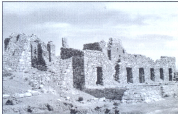
Ruinas de la planta de tratamiento construida por Germán Avé Lallemand en 1889.
