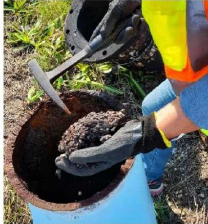
Fig. 7 Costra de sedimentos en un ducto de petróleo abandonado (Foto del autor)
