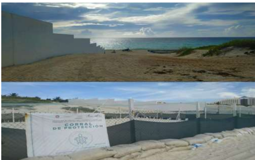
Figura N° 2. Obra en proceso del Grupo Solaris en playa delfines, Cancún. Fuente: Fotografías propias tomadas en campo.
