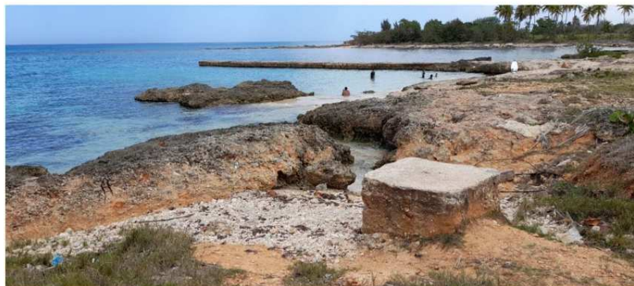
Fig. 11. Estado actual de la erosión costera, inestabilidad de taludes y subsidencia local (febrero 2022) en el litoral de El Salado (Foto LML)
