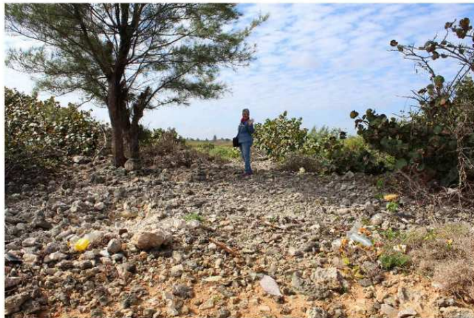
Fig. 22. Camellón de marea modificado y parcialmente desmantelado por la acción erosivo-acumulativa del oleaje durante el paso del Huracán Irma (Foto LML, tomada desde la costa y hacia el sur)
