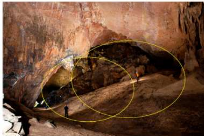
Fig. 12. Clasificación asociada al “efecto de vecindad” (elipses amarillas). Dos galerías naturales paralelas en la Galería XX Aniversario, del Sistema Cavernario Majaguas-Cantera (Pinar del Río, Cuba) donde la distribución de tensiones se superpone y ha provocado un incremento en la debilidad estructural de esa sección del sistema subterráneo (Foto Vladimir Otero)
